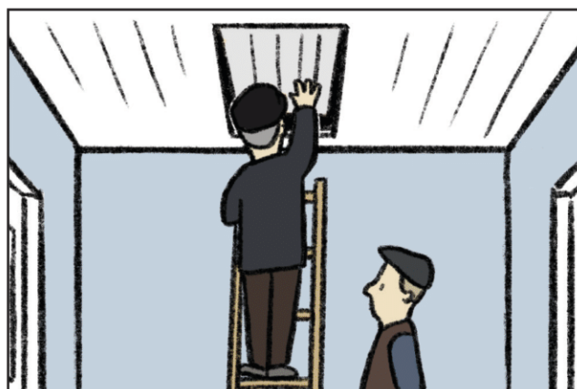
Astupăm toate crăpăturile: montăm benzi izolante la uși, închidem gura podului
