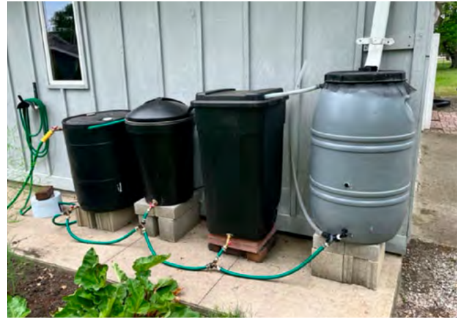
Sistemul de colectare a apelor pluviale alcătuit din mai multe containere (foto din internet)
